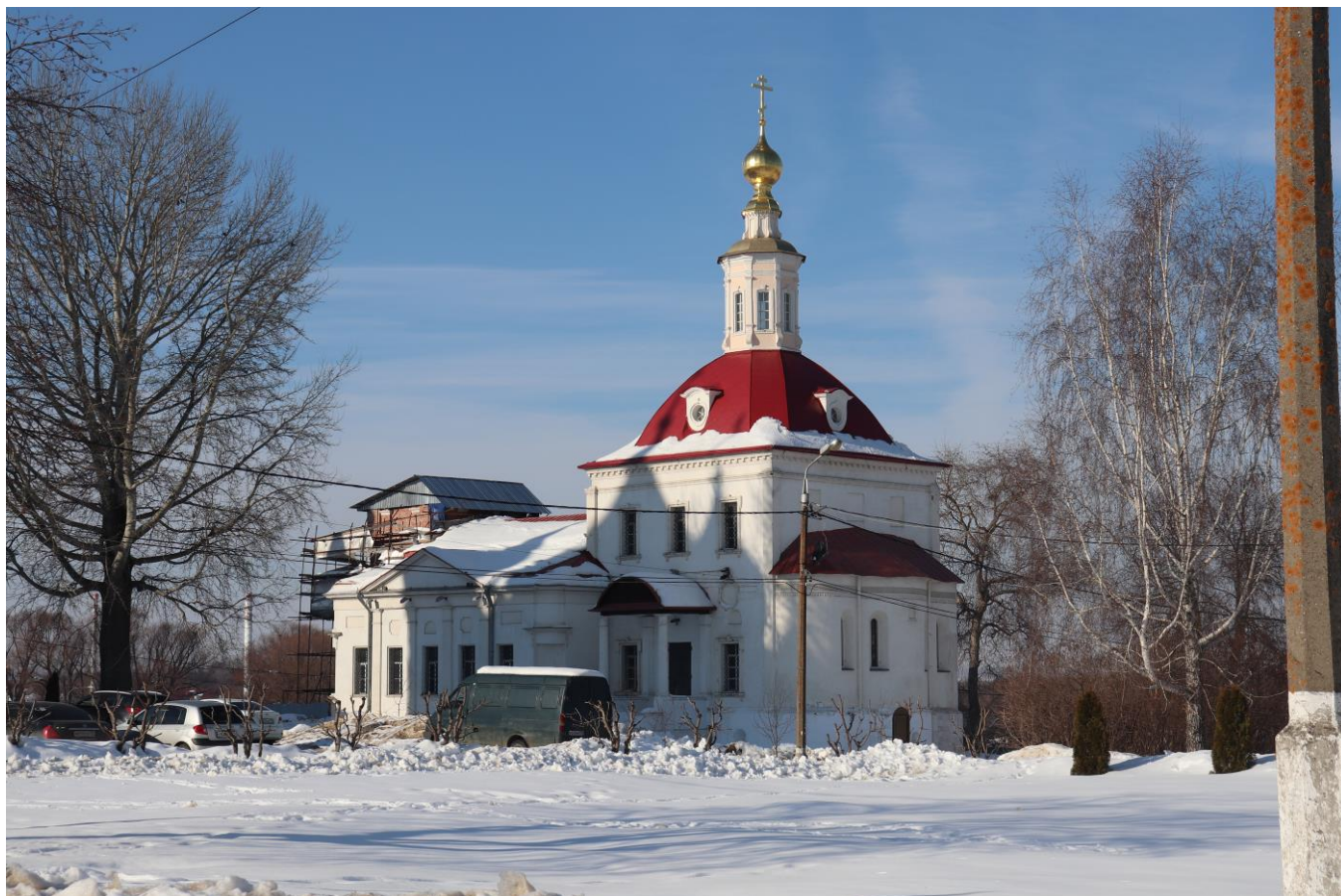
Церковь Воскресения Слоущего, что в Крепости, в Коломне.
